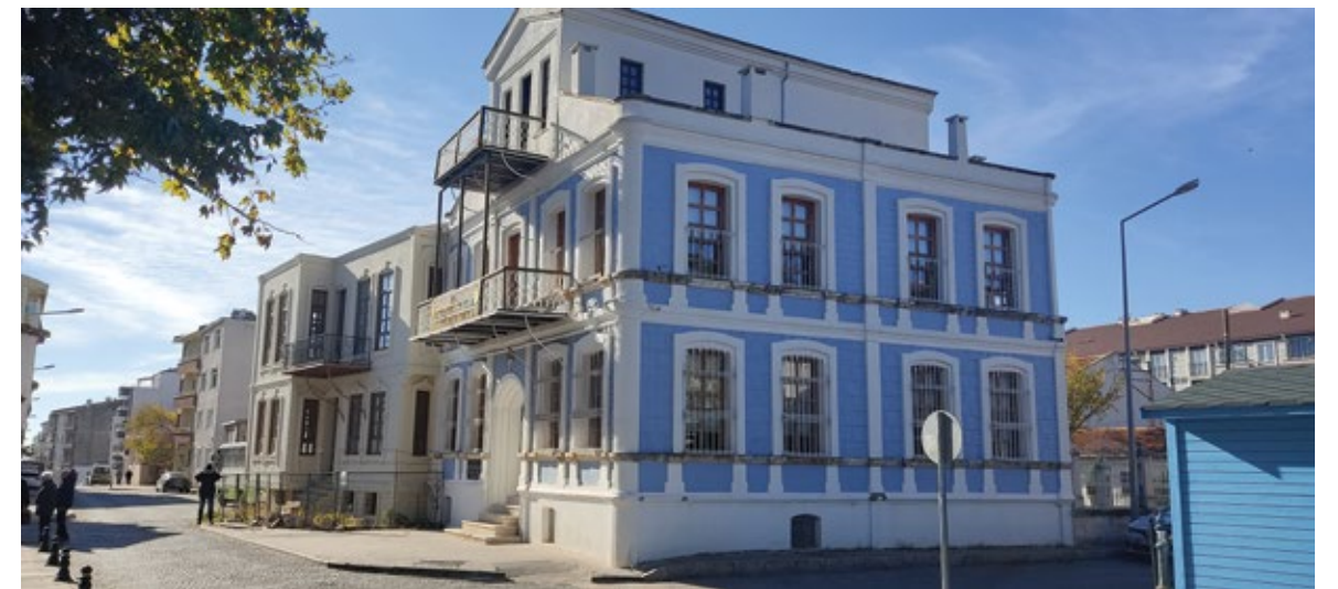
Εἰκ. 9: Τα σπίτια τῶν Δημητρίου Δοδόπουλου (γαλάζιο) καὶ Βασιλείου Μελανίωνος, ἀνακατασκευασμένα. Φωτογραφία ἀπὸ Δημ. Κιηγημά, 2024.
